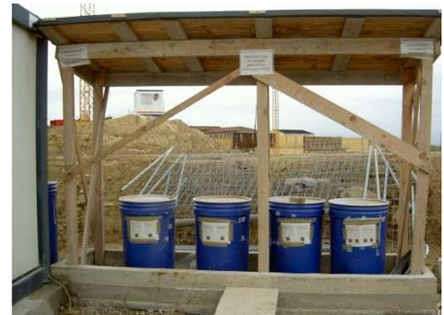
Los cubetos de retención de vertidos deben contener un volumen equivalente al máximo entre: el depósito de mayor volumen y el 10 % de volumen total almacenado. Esta condición se establece para el almacenamiento de residuos peligrosos en depósitos fijos o en cualquier otro tipo de envase (construido alrededor de la zona impermeable, o para los cubetos prefabricados).
