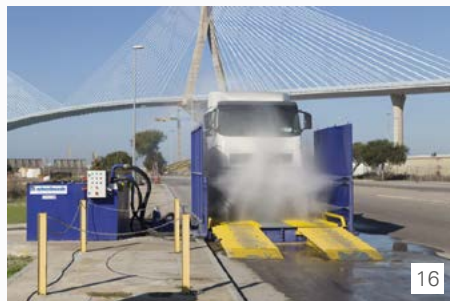
14. Plantación de arbolado a modo de barrera natural 15. Ubicación de la instalación lavaruedas. 16. Lavaruedas en operación. 17. Recorrido propuesto.
