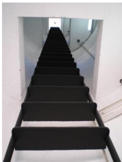
Vista de escala de ascenso en Faro de Barbate
