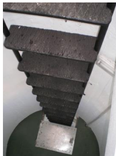
Vista de trampillas que han de cerrarse al ir ascendiendo.
