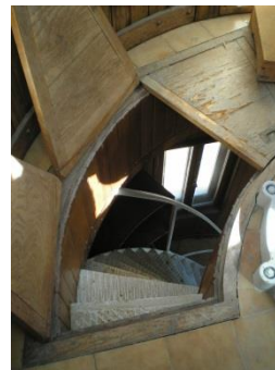
Vista de trampilla en Faro de Cádiz
