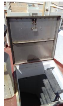
Vista de trampilla en Faro de Barbate
