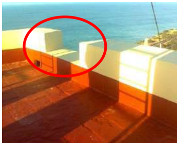
Vista de cubierta con pretil bajo en Faro de Roche
