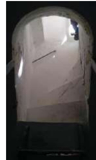
Vista de escalera de ascenso en Faro de Sancti Petri.
