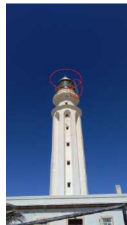
Vista de escala exterior de ascenso a la cúpula en Faro de Trafalgar
