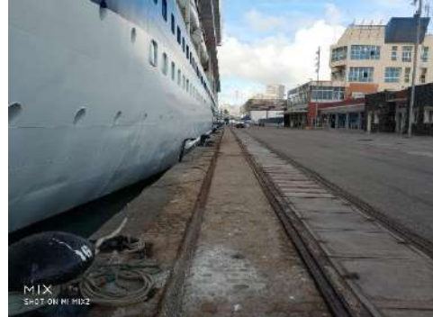
Muelle Alfonso XIII, se caracteriza por la presencia de Cruceros y la realización de servicios comerciales y portuarios asociados a los mismos
