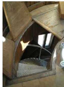
Vista de trampilla en Faro de Cádiz
