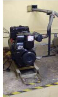
Vista de tuberías de generadores en faro de Roche
