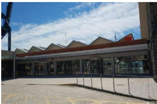
Terminal de pasajeros de la Estación Marítima Muelle Alfonso XIII
