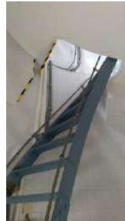
Vista de escala de ascenso Faro de Trafalgar
