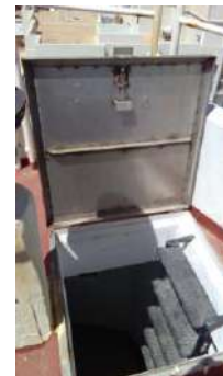
Vista de trampilla en Faro de Barbate
