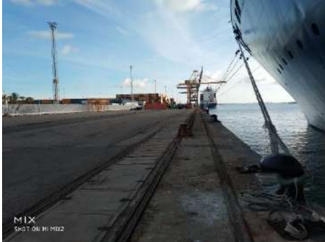
Muelle Reina Sofia, se caracteriza por la presencia de grúas portacontenedores y realización de estiba/desestiba de contenedores
