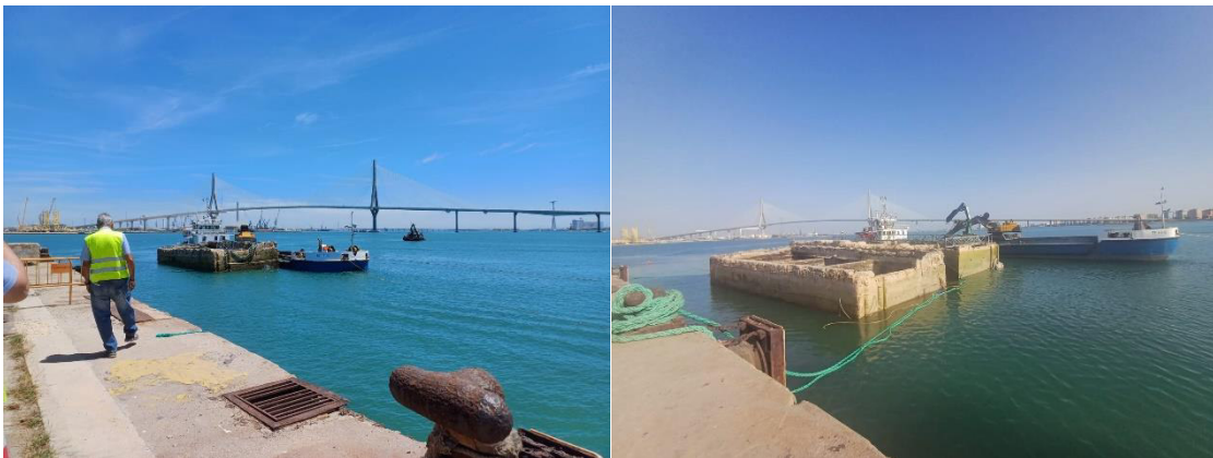
Ilustración 1. Reflote y atraque de los cajones reflotados de Navantia
