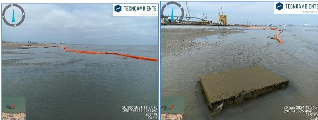
**Ilustración 3. Posición de la barrera antiturbidez y estado de la misma**
