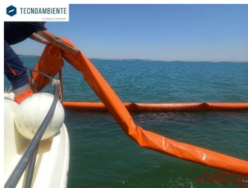
Ilustración 4. Comprobación de fijación de la barrera el 02/07/24
