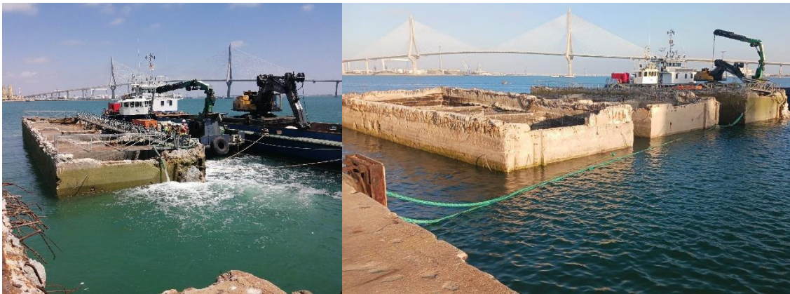
Ilustración 1. Reflote y atraque de los cajones reflatados de Navantia
