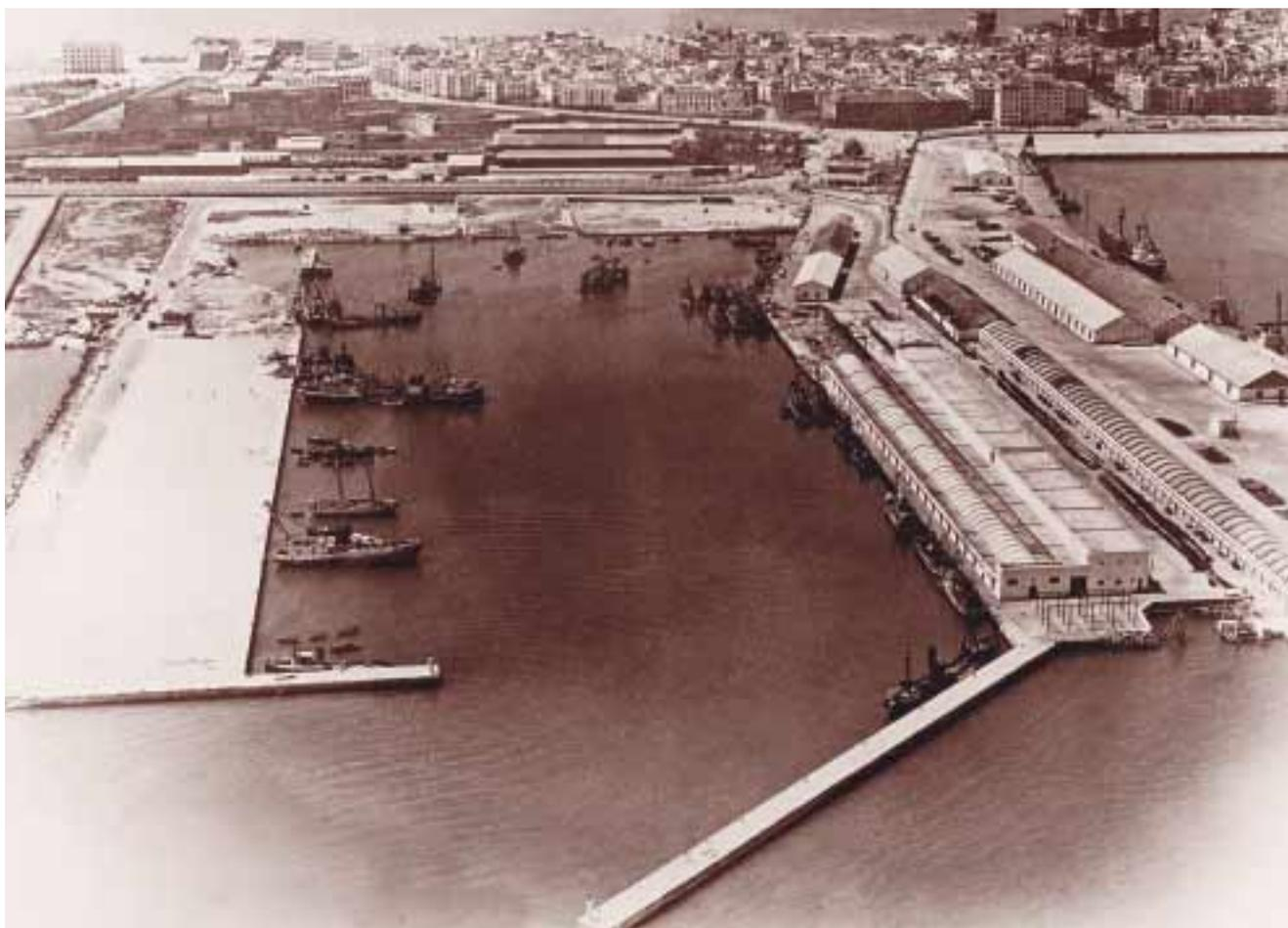
*Panorámica del Puerto Pesquero en 1952. Se puede apreciar la ejecución de 3 proyectos: “Muelle de Levante 2ª etapa”, que comprendía la reconstrucción y terminación de los 335 metros ya construidos y la nueva construcción de 150 metros más. Este proyecto se redactó en 1950 y empezó a ejecutarse en 1952, quedando terminado en 1953.*
