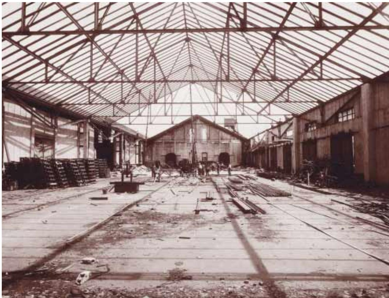
*Durante 1948 se procedió a la reconstrucción de los almacenes dañados por la explosión de 1947. En la imagen vemos el estado de las obras en el Almacén núm. 1 en julio de ese año. El importe de los trabajos de reconstrucción por los daños causados en los almacenes del puerto fue de 3.179.149 pesetas distribuidas en:*
