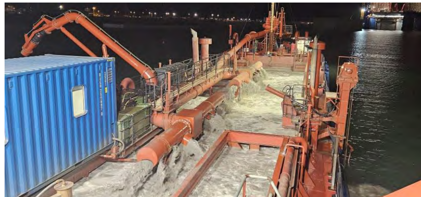
Figura 02 - Seguimiento y control arqueológico de la Fase II de la ampliación de la NTC, a bordo de la Viking R Supervisión de las labores de dragado, trazado, tipo de sedimento.
