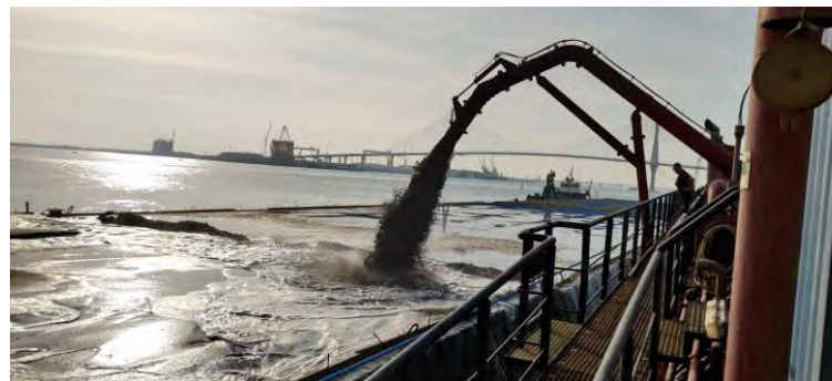
Figura 01 - Seguimiento y control arqueológico del dragado a bordo de la Viking R para la fase II de la ampliación de la NTC. Revisión de la descarga en el cajón 2.
