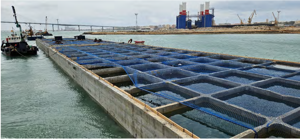
Figura 5. Vista de cajones.
