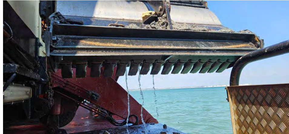
Figura 05- Seguimiento y control arqueológico del dragado para la Fase II de la ampliación de la NTC, a bordo de la Viking R. Revisión de la limpieza de la cabeza de succión al finalizar la 3ª carga del turno. Material de desecho. Resultado negativo.
