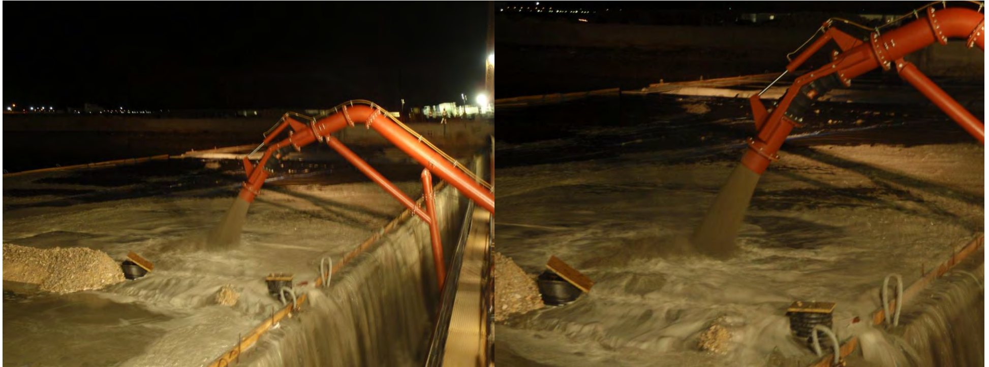
Figura 01 y 02 - Seguimiento y control arqueológico del dragado para la Fase II de la ampliación de la NTC, a bordo de la Viking R. Supervisión del vertido de arena mediante la lanza para el relleno de cajones.
