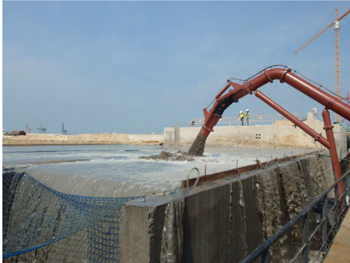
Figura 01 - Seguimiento y control arqueológico del dragado para la Fase II de la ampliación de la NTC, a bordo de la Viking R. Supervisión del vertido de arena mediante la lanza para el relleno de cajones.
