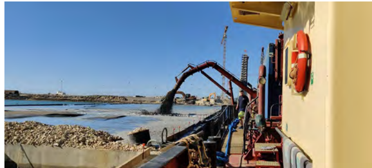
Figura 04 - Seguimiento y control arqueológico del dragado a bordo de la Viking R para la fase II de la ampliación de la NTC. Descarga en la nueva fase de la nueva terminal de contenedores, relleno de cajones.
