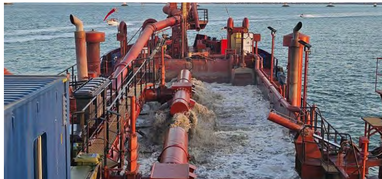
Figura 01 - Seguimiento y control arqueológico de la Fase II de la ampliación de la NTC, a bordo de la Viking R. Supervisión de las labores de dragado, trazado, tipo de sedimento,..
