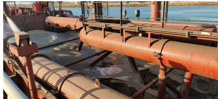
Figura 03 - Seguimiento y control arqueológico del dragado a bordo de la Viking R para la fase II de la ampliación de la NTC. Detalle del sedimento arenoso depositado en la cántara, este sedimento es originario del dragado en la bocana y sirve como relleno de los cajones.
