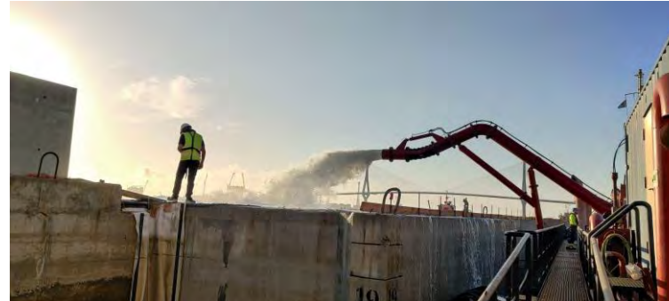
Figura 02 - Seguimiento y control arqueológico del dragado a bordo de la Viking R para la fase II de la ampliación de la NTC. Vertido en la cara interior de los cajones.
