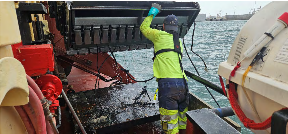
Figura 8. Labores de limpieza, cabezal de la draga.
