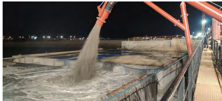
Figura 03 - Seguimiento y control arqueológico del dragado a bordo de la Viking R para la fase II de la ampliación de la NTC. Vertido en los cajones.
