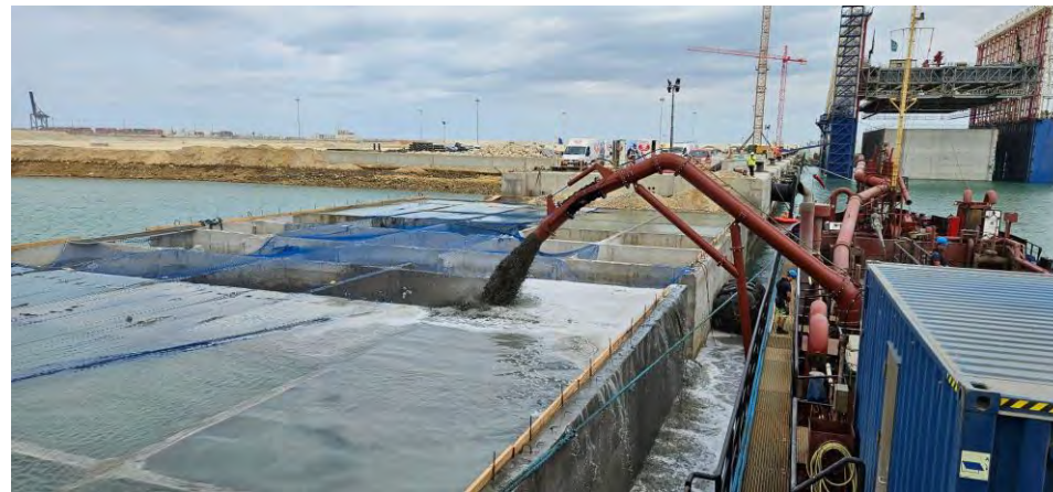
Figura 06 - Seguimiento y control arqueológico del dragado para la Fase II de la ampliación de la NTC, a bordo de la Viking R. Supervisión de la 2ª descarga del turno. Relleno del cajón 01 por su cara externa. área de vertido,
