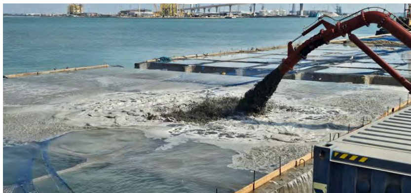
Figura 04 - Seguimiento y control arqueológico del dragado para la Fase II de la ampliación de la NTC, a bordo de la Viking R. Supervisión de la 3ª descarga del turno. Relleno del cajón 01 por su cara interna. área de vertido.
