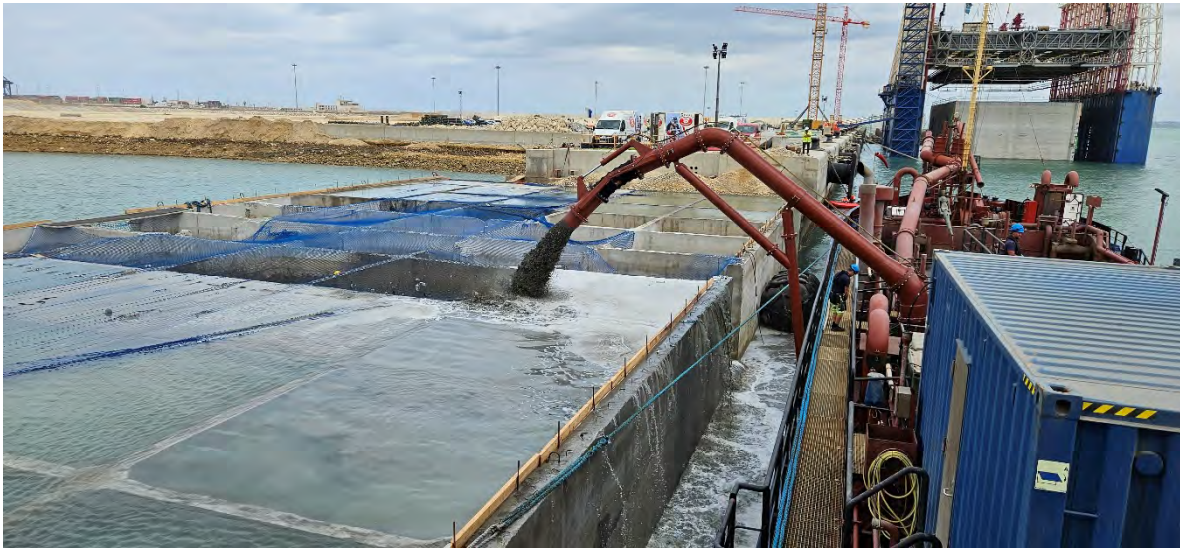
Figura 6. Relleno de cajones
