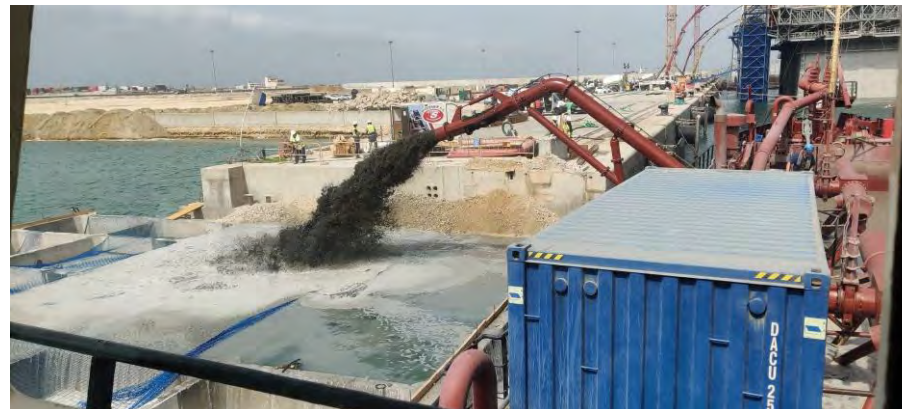
Figura 04 - Seguimiento y control arqueológico del dragado a bordo de la Viking R para la fase II de la ampliación de la NTC. Relleno de cajones con el material extraído de la bocana junto a la punta de San Felipe.
