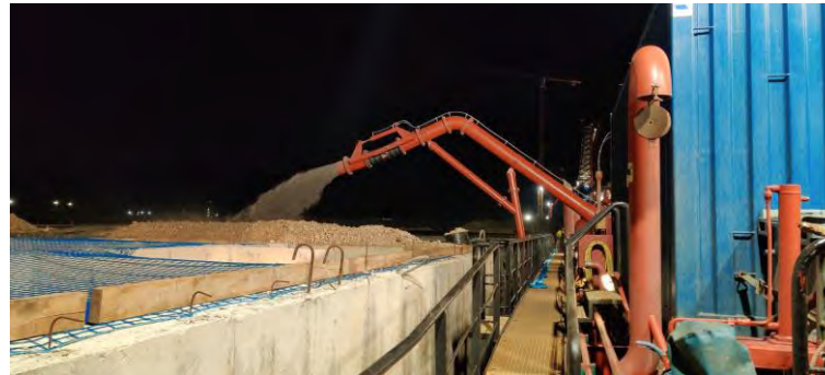
Figura 01 - Seguimiento y control arqueológico del dragado a bordo de la Viking R para la fase II de la ampliación de la NTC. Descarga en la línea de cajones.
