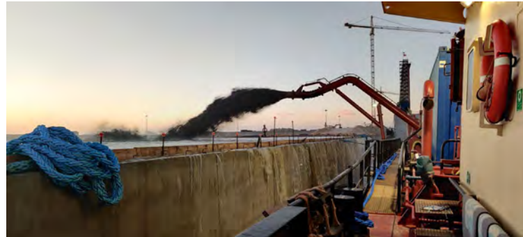
Figura 01 - Seguimiento y control arqueológico del dragado a bordo de la Viking R para la fase II de la ampliación de la NTC. Vertido en la línea de cajones.
