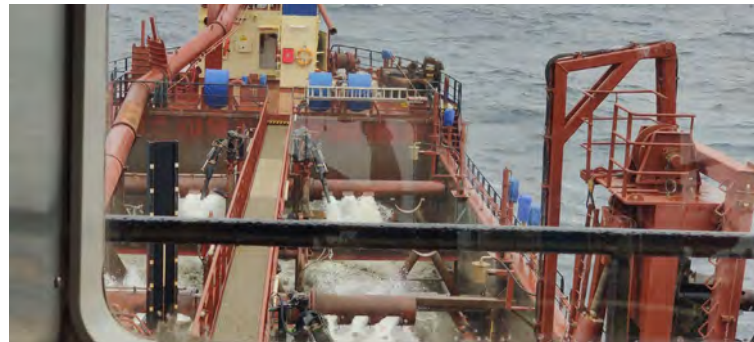
Figura 04 - Seguimiento y control arqueológico del dragado a bordo de la Viking R para la fase II de la ampliación de la NTC. Descarga en zona habilitada.
