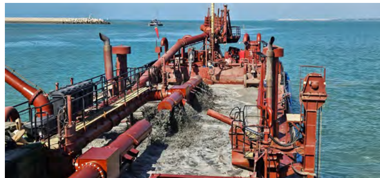
Figura 02 - Seguimiento y control arqueológico de la Fase II de la ampliación de la NTC, a bordo de la Viking R. Supervisión de las labores de dragado, trazado, tipo de sedimento, posición de la draga en la zona de la bocana del puerto de Cádiz durante la 1ª carga iniciada en el turno.
