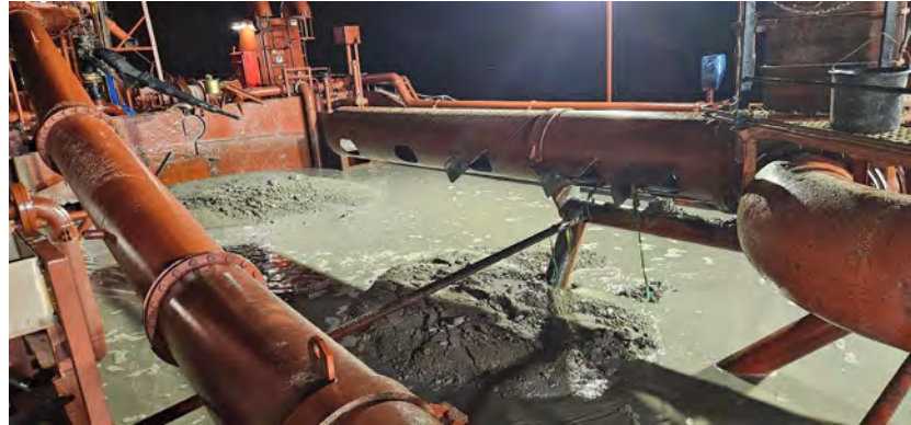
Figura 01 - Seguimiento y control arqueológico del dragado para la Fase II de la ampliación de la NTC, a bordo de la Viking R. Supervisión de la cántara tras la 1ª carga completada. Detalle del sedimento extraído. Resultado negativo.
