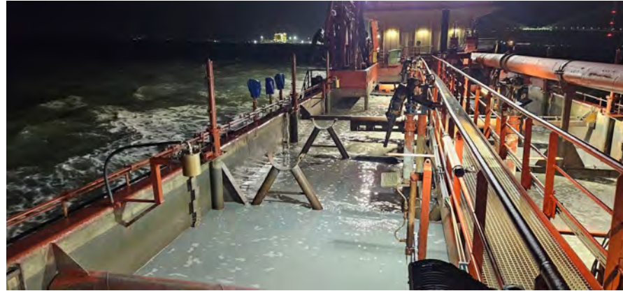
Figura 02 - Seguimiento y control arqueológico del dragado para la Fase II de la ampliación de la NTC, a bordo de la Idun R. Supervisión de la cántara tras la 1ª carga completada. La cantidad de agua mantenida a bordo, imposibilita la revisión completa del material extraído. Resultado negativo.
