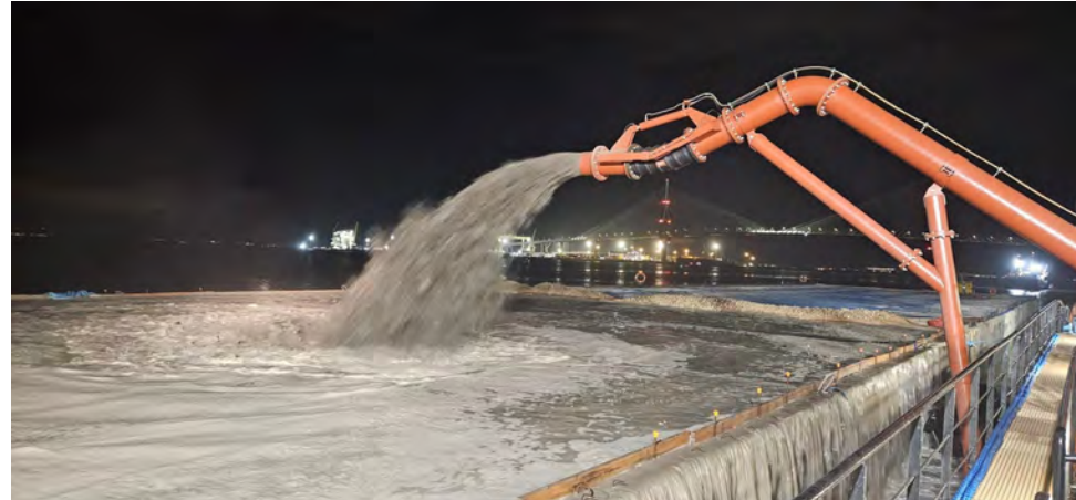
Figura 03 - Seguimiento y control arqueológico del dragado para la Fase II de la ampliación de la NTC, a bordo de la Viking R. Supervisión de la 4ª descarga del turno. Relleno del cajón 03 por su cara interna.
