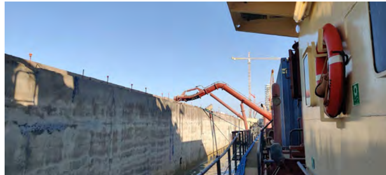
Figura 02 - Seguimiento y control arqueológico del dragado a bordo de la Viking R para la fase II de la ampliación de la NTC. Descarga en el cajón 3.
