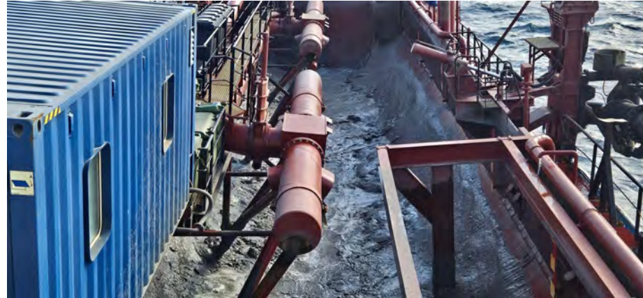
Figura 05 - Seguimiento y control arqueológico de la Fase II de la ampliación de la NTC, a bordo de la Viking R Supervisión de la única descarga realizada en el turno, posicionamiento de la draga, tipo de sedimento,..
