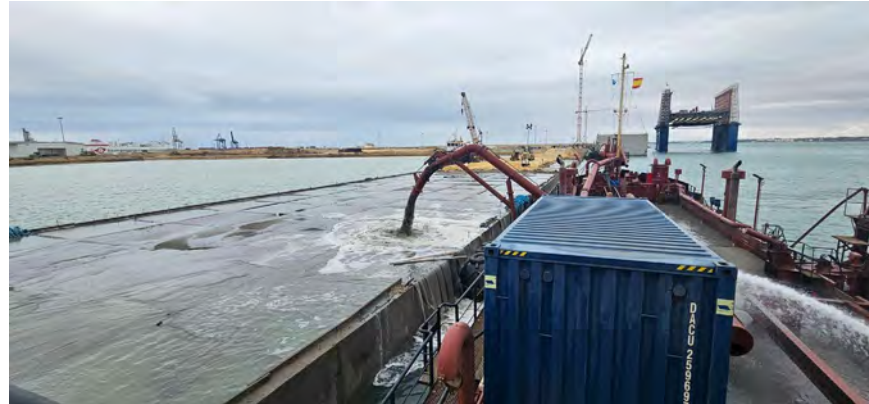
Figura 05 - Seguimiento y control arqueológico del dragado para la Fase II de la ampliación de la NTC, a bordo de la Viking R. Supervisión de la 3ª descarga del turno. Relleno del cajón 03 por su cara externa.
