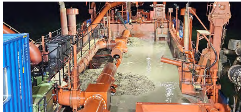
Figura 02 - Seguimiento y control arqueológico del dragado para la Fase II de la ampliación de la NTC, a bordo de la Viking R. Supervisión de la cántara tras la 1ª carga del turno. La cantidad de agua mantenida a bordo imposibilita la revisión total del material extraído. Resultado negativo.
