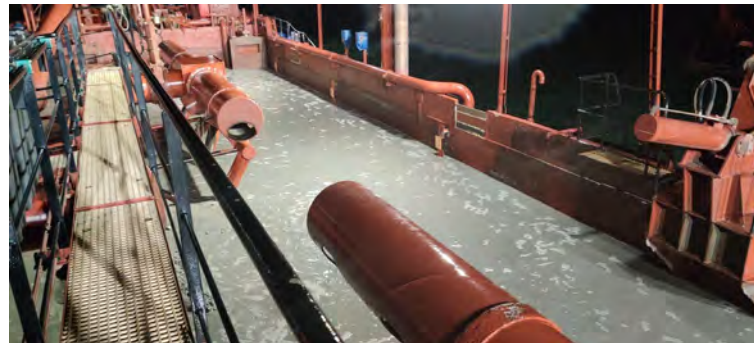
Figura 02 - Seguimiento y control arqueológico del dragado a bordo de la Viking R para la fase II de la ampliación de la NTC. Revisión de la cántara llena de agua dificultando la inspección.
