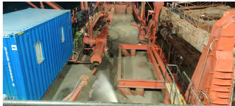
Figura 01 - Seguimiento y control arqueológico del dragado a bordo de la Viking R para la fase II de la ampliación de la NTC. Vertido en el muelle 5.
