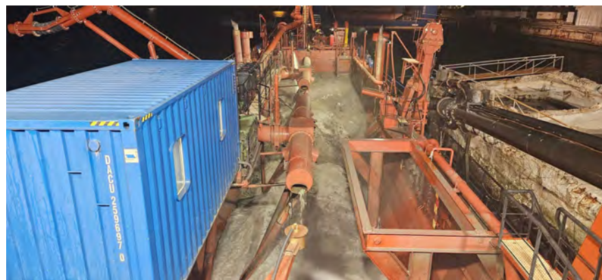
Figura 04 - Seguimiento y control arqueológico de la Fase II de la ampliación de la NTC, a bordo de la Viking R. Supervisión de la 3ª descarga realizada en el turno a través de tubería para el relleno de la dársena.
