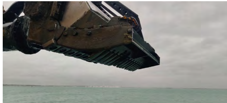
Figura 02 - Seguimiento y control arqueológico del dragado a bordo de la Viking R para la fase II de la ampliación de la NTC. Revisión del cabezal en la primera carga con resultado positivo.
