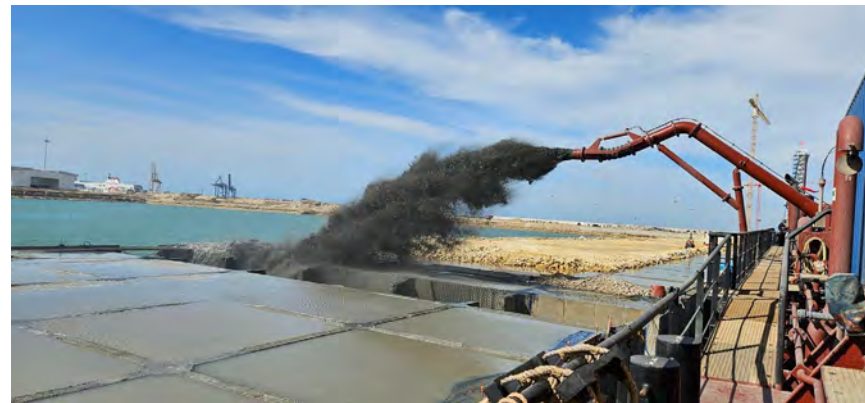
Figura 04 - Seguimiento y control arqueológico de la Fase II de la ampliación de la NTC, a bordo de la Viking R. Supervisión de la 2ª descarga realizada en el turno con lanza para rellenar el cajón 04.
