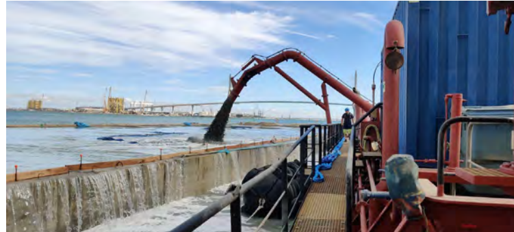
Figura 02 - Seguimiento y control arqueológico del dragado a bordo de la Viking R para la fase II de la ampliación de la NTC. Vertido en el cajón 3 por la cara interior.
