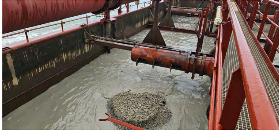
Figura 03 - Seguimiento y control arqueológico del dragado para la Fase II de la ampliación de la NTC, a bordo de la Idun R. Supervisión de la cántara tras la 1ª carga completada en el turno. Detalle del sedimento extraído. La cantidad de agua mantenida a bordo, imposibilita la revisión completa del material extraído. Resultado negativo.
