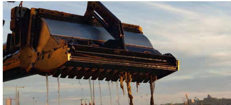
Figura 01 - Seguimiento y control arqueológico del dragado a bordo de la Viking R para la fase II de la ampliación de la NTC. Detalle del cabezal con material de desecho en la primera carga.
