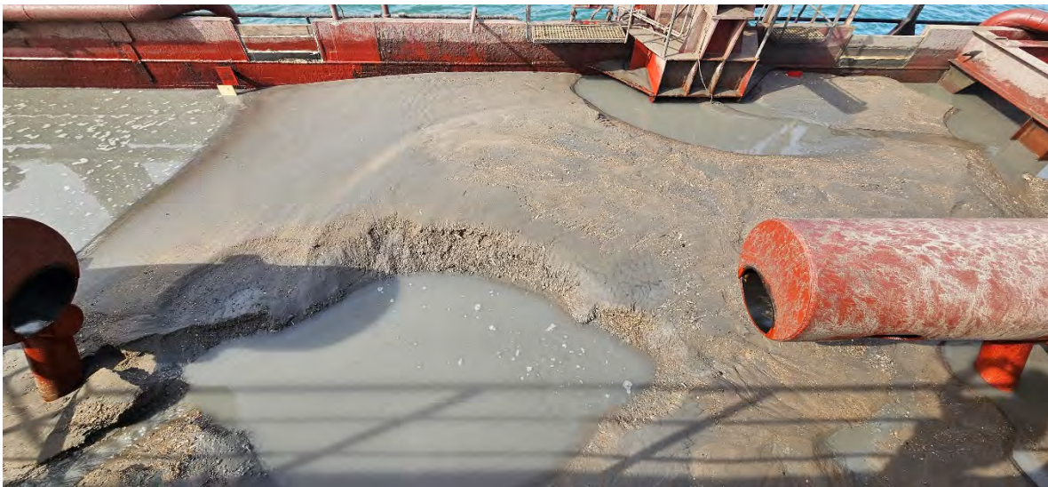
Figura 6. Material dragado en la bocana usado para rellenar cajones e interior recinto.
