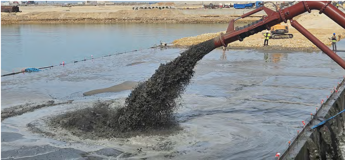
Figura 8. Relleno de cajones
