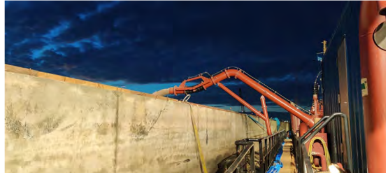
Figura 03 - Seguimiento y control arqueológico del dragado a bordo de la Viking R para la fase II de la ampliación de la NTC. Vertido en la línea de cajones para su relleno.
