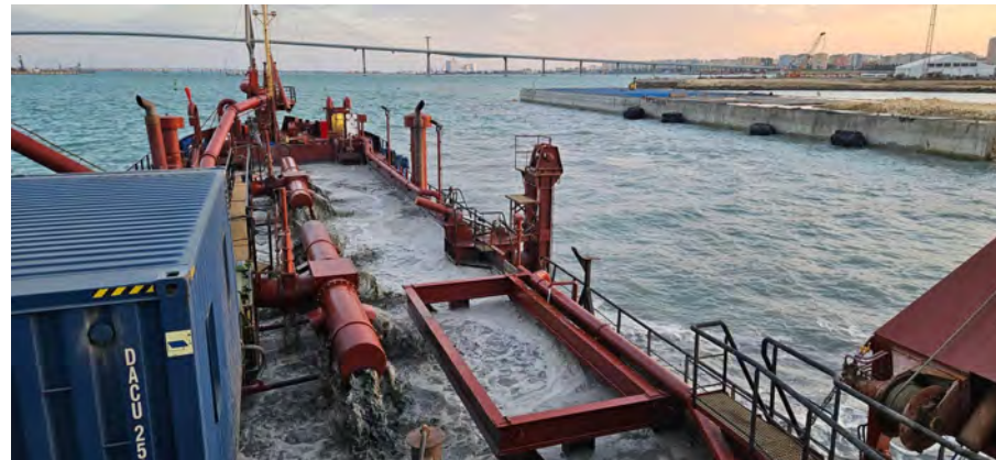
Figura 06 - Seguimiento y control arqueológico de la Fase II de la ampliación de la NTC, a bordo de la Viking R Supervisión de las labores de dragado, trazado, tipo de sedimento, posición de la draga en la zona de reviro y frente de cajones de la NTC durante la 2ª carga iniciada en el turno.
