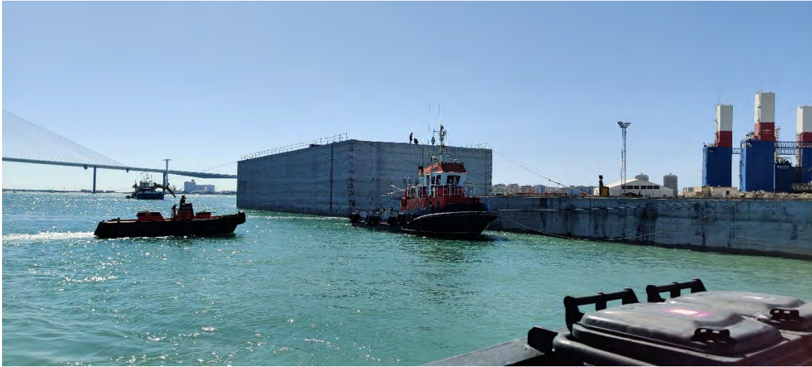
Figura 7. Colocación de un cajón.
