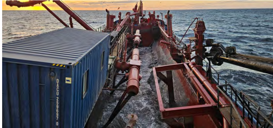
Figura 07 - Seguimiento y control arqueológico de la Fase II de la ampliación de la NTC, a bordo de la Viking R. Supervisión de la 2ª descarga realizada en el turno, tipo de sedimento, y posicionamiento de la draga en el área de vertido habilitada.
