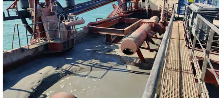
Figura 04 - Seguimiento y control arqueológico del dragado a bordo de la Viking R para la fase II de la ampliación de la NTC. Detalle del material dragado en la bocana.
