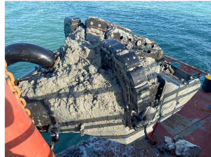
Figura 02 - Seguimiento y control arqueológico del dragado a bordo de la SIF R- Inspección de la cabeza de succión de la draga. Se acumula gran cantidad de fango en la parte superior.
