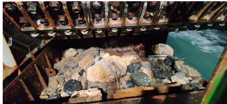
Figura 01 - Seguimiento y control arqueológico de la Fase II de la ampliación de la NTC. Revisión de la cabeza en la segunda carga.
