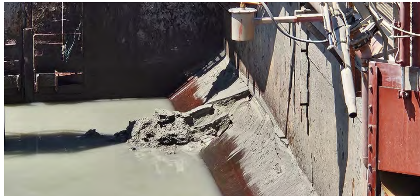
Figura 02- Seguimiento y control arqueológico del dragado para la Fase II de la ampliación de la NTC, a bordo de la SIF R. Supervisión de la 1ª descarga del turno, área de vertido, detalle del tipo de sedimento (limo arenoso).
