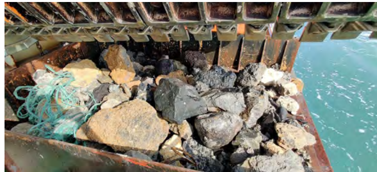
Figura 01 - Seguimiento y control arqueológico de la Fase II de la ampliación de la NTC. Revisión de la cabeza en la primera carga. Enrase de los cajones.
