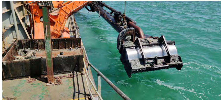
Figura 03 - Seguimiento y control arqueológico de la Fase II de la ampliación de la NTC. Revisión de la cabeza en la segunda carga.
