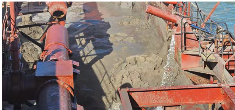
Figura 04 - Seguimiento y control arqueológico de la Fase II de la ampliación de la NTC, a bordo de la Viking R. Supervisión de la 2ª descarga realizada en el turno a través de tubería para el relleno de la dársena.
