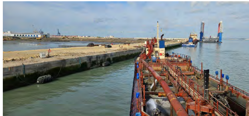
Figura 08 - Seguimiento y control arqueológico de la Fase II de la ampliación de la NTC, a bordo de la Idun R. Supervisión de la 2ª descarga realizada en el turno a través de tubería para el relleno de la dársena.
