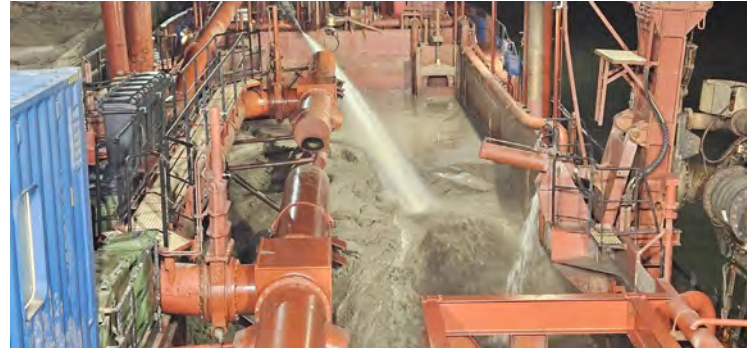
Figura 05 - Seguimiento y control arqueológico de la Fase II de la ampliación de la NTC, a bordo de la Viking R Supervisión de la 1ª descarga realizada en el turno a través de tubería para el relleno de la dársena.
