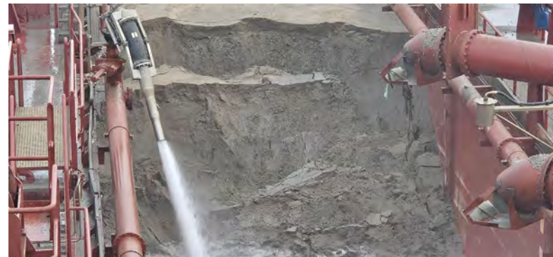
Figura 08 - Seguimiento y control arqueológico de la Fase II de la ampliación de la NTC, a bordo de la Brage R. Supervisión de la 2ª descarga realizada en el turno a través de tubería para el relleno de la dársena.
