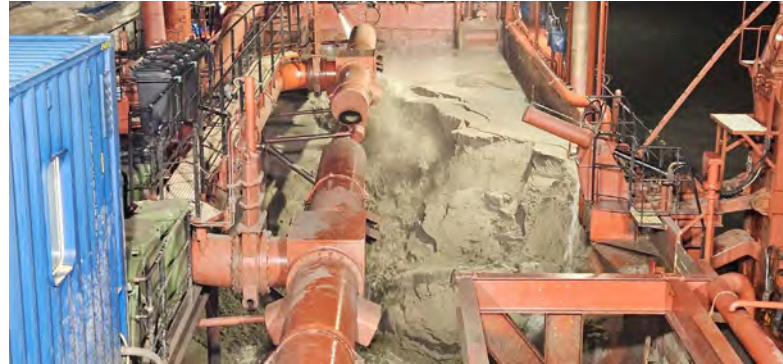
Figura 11 - Seguimiento y control arqueológico de la Fase II de la ampliación de la NTC, a bordo de la Viking R Supervisión de la 4ª descarga realizada en el turno a través de tubería para el relleno de la dársena.
