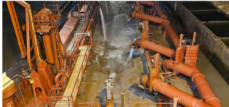
Figura 03 - Seguimiento y control arqueológico de la Fase II de la ampliación de la NTC, a bordo de la Brage R Supervisión de la 1ª descarga realizada en el turno a través de tubería para el relleno de la dársena.
