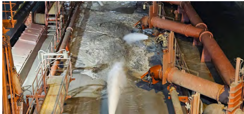
Figura 08 - Seguimiento y control arqueológico de la Fase II de la ampliación de la NTC, a bordo de la Brage R. Supervisión de la 2ª descarga realizada en el turno a través de tubería para el relleno de la dársena.
