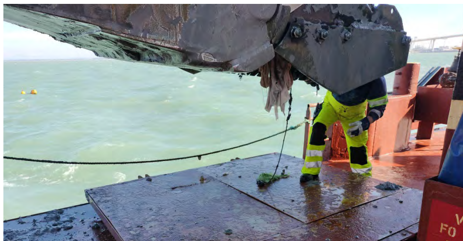
Figuras 02 – Seguimiento y control arqueológico de la Fase II de la ampliación de la NTC a bordo de la Brage R. Revisión de la limpieza de la cabeza de succión tras la 2ª carga del turno de día. Material de desecho. Resultado negativo.
