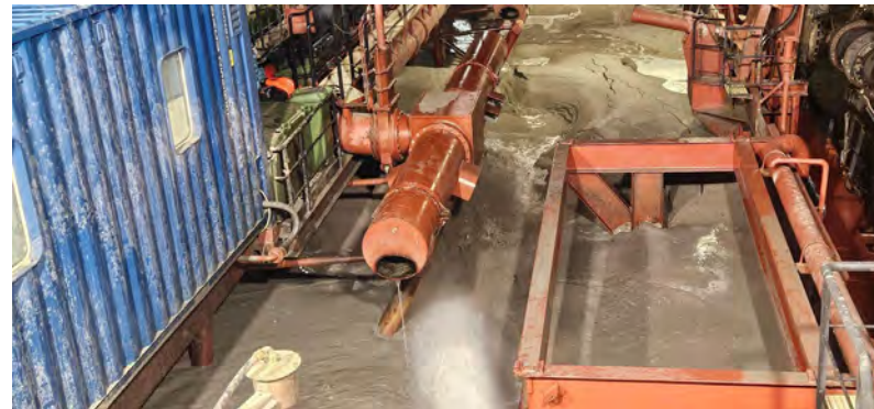
Figura 04 - Seguimiento y control arqueológico de la Fase II de la ampliación de la NTC, a bordo de la Viking R. Supervisión de la 2ª descarga realizada en el turno a través de tubería para el relleno de la dársena.
