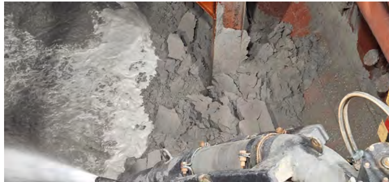
Figura 15 - Seguimiento y control arqueológico de la Fase II de la ampliación de la NTC, a bordo de la Viking R. Supervisión de la 5ª descarga realizada en el turno a través de tubería para el relleno de la dársena.
