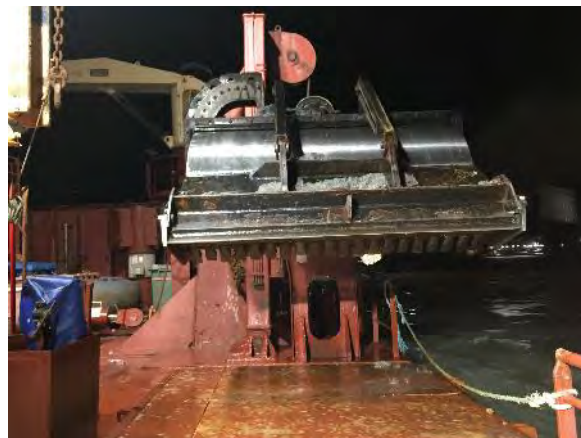
Figura 02 - Seguimiento y control arqueológico del dragado para la Fase II de la ampliación de la NTC, a bordo de la Brage R. Imágenes del cabezal de succión y del sedimento extraído en la tolva tras la segunda carga. Resultado negativo.
