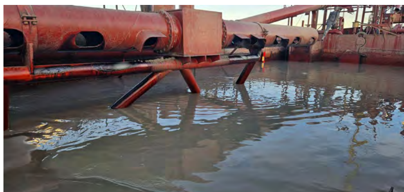
Figura 10 - Seguimiento y control arqueológico del dragado para la Fase II de la ampliación de la NTC, a bordo de la Viking R. Supervisión de la cántara tras la 3ª carga completada. Resultado negativo.
