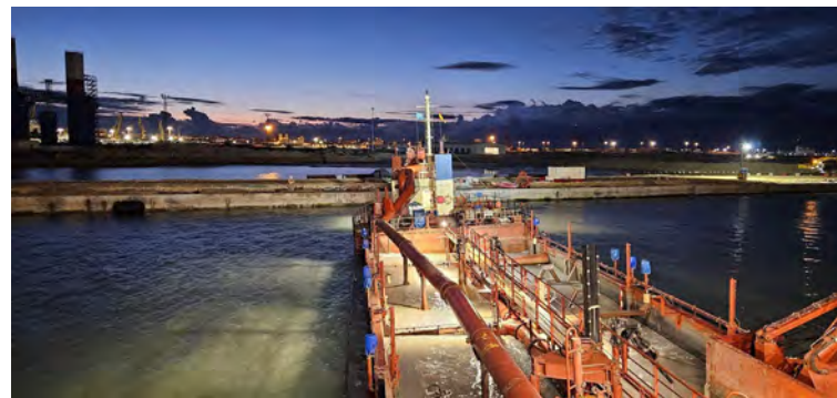
Figura 16 - Seguimiento y control arqueológico de la Fase II de la ampliación de la NTC, a bordo de la Idun R. Supervisión de la 4ª descarga realizada en el turno a través de tubería para el relleno de la dársena.
