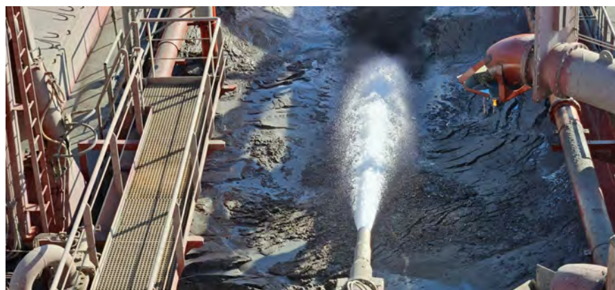
Figura 08 - Seguimiento y control arqueológico de la Fase II de la ampliación de la NTC, a bordo de la Brage R. Supervisión de la 2ª descarga realizada en el turno a través de tubería para el relleno de la dársena.
