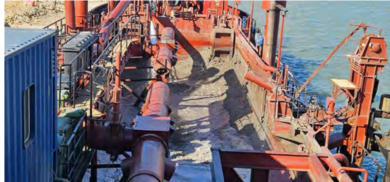
Figura 11 - Seguimiento y control arqueológico de la Fase II de la ampliación de la NTC, a bordo de la Viking R Supervisión de la 3ª descarga realizada en el turno a través de tubería para el relleno de la dársena.
