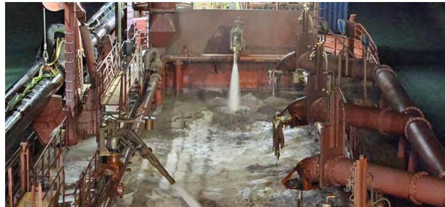
Figura 04 - Seguimiento y control arqueológico de la Fase II de la ampliación de la NTC, a bordo de la Brage R. Supervisión de la 1ª descarga realizada en el turno a través de tubería para el relleno de la dársena.
