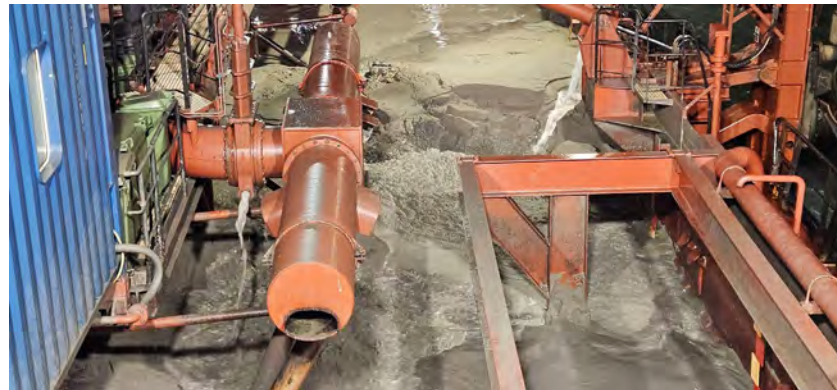
Figura 10 - Seguimiento y control arqueológico de la Fase II de la ampliación de la NTC, a bordo de la Viking R. Supervisión de la 4ª descarga realizada en el turno a través de tubería para el relleno de la dársena.
