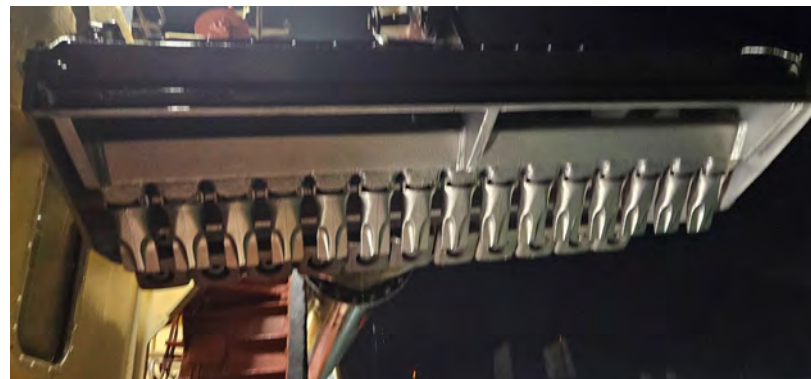
Figura 02 - Seguimiento y control arqueológico del dragado para la Fase II de la ampliación de la NTC, a bordo de la Viking R. Revisión de la limpieza de la cabeza de succión durante la primera carga completada en el turno. Resultado negativo.
