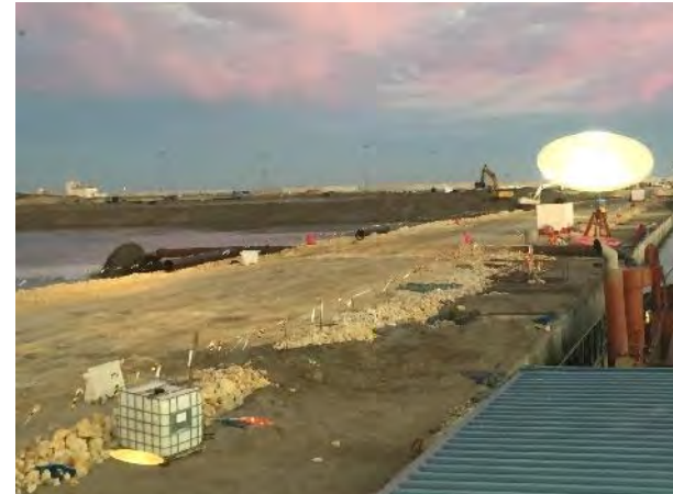
Figura 01 - Seguimiento y control arqueológico del dragado para la Fase II de la ampliación de la NTC, a bordo de la Viking R. Imágenes del proceso de descarga mediante tubería en la dársena.
