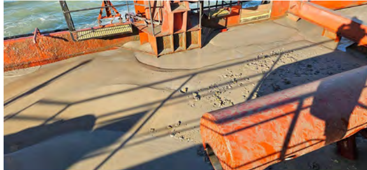
Figura 03 - Seguimiento y control arqueológico del dragado para la Fase II de la ampliación de la NTC, a bordo de la Viking R. Supervisión de la cántara tras la primera carga completada en el turno. Resultado negativo.
