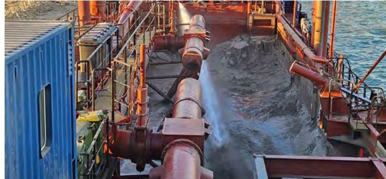
Figura 15 - Seguimiento y control arqueológico de la Fase II de la ampliación de la NTC, a bordo de la Viking R. Supervisión de la 3ª descarga realizada en el turno a través de tubería para el relleno de la dársena.
