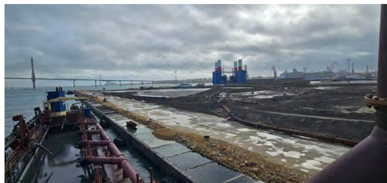
Figura 08 - Seguimiento y control arqueológico de la Fase II de la ampliación de la NTC, a bordo de la Brage R. Supervisión de la 2ª descarga realizada en el turno a través de tubería para el relleno de la dársena.
