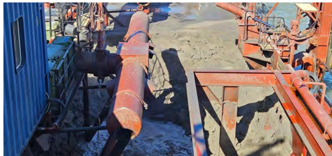
Figura 08 - Seguimiento y control arqueológico de la Fase II de la ampliación de la NTC, a bordo de la Viking R. Supervisión de la 2ª descarga realizada en el turno a través de tubería para el relleno de la dársena.
