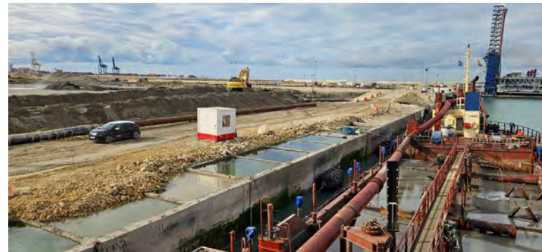
Figura 12 - Seguimiento y control arqueológico de la Fase II de la ampliación de la NTC, a bordo de la Idun R. Supervisión de la 3ª descarga realizada en el turno a través de tubería para el relleno de la dársena.
