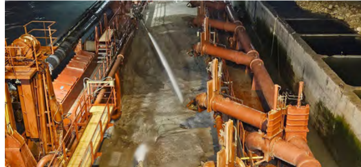
Figura 07 - Seguimiento y control arqueológico de la Fase II de la ampliación de la NTC, a bordo de la Brage R Supervisión de la 3ª descarga realizada en el turno a través de tubería para el relleno de la dársena.
