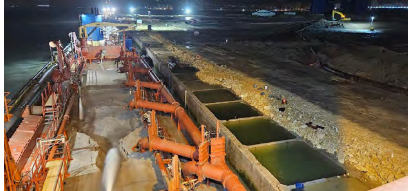
Figura 07 - Seguimiento y control arqueológico de la Fase II de la ampliación de la NTC, a bordo de la Brage R Supervisión de la 2ª descarga realizada en el turno a través de tubería para el relleno de la dársena.
