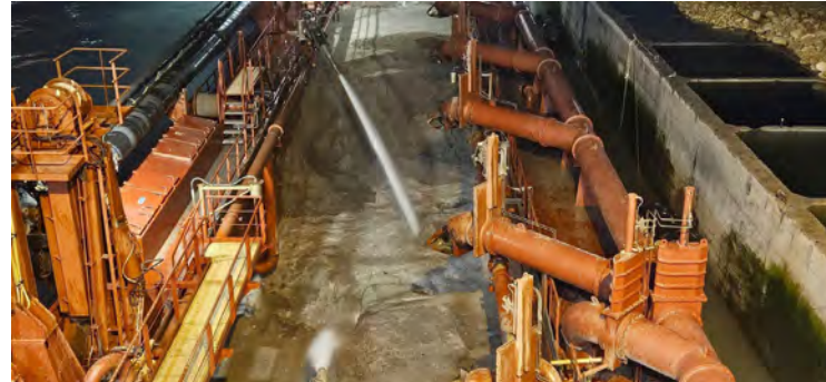
Figura 07 - Seguimiento y control arqueológico de la Fase II de la ampliación de la NTC, a bordo de la Brage R Supervisión de la 3ª descarga realizada en el turno a través de tubería para el relleno de la dársena.
