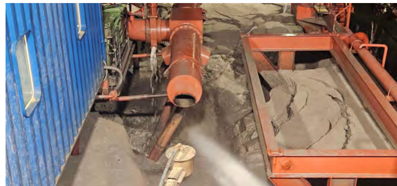
Figura 10 - Seguimiento y control arqueológico de la Fase II de la ampliación de la NTC, a bordo de la Viking R. Supervisión de la 3ª descarga realizada en el turno a través de tubería para el relleno de la dársena.
