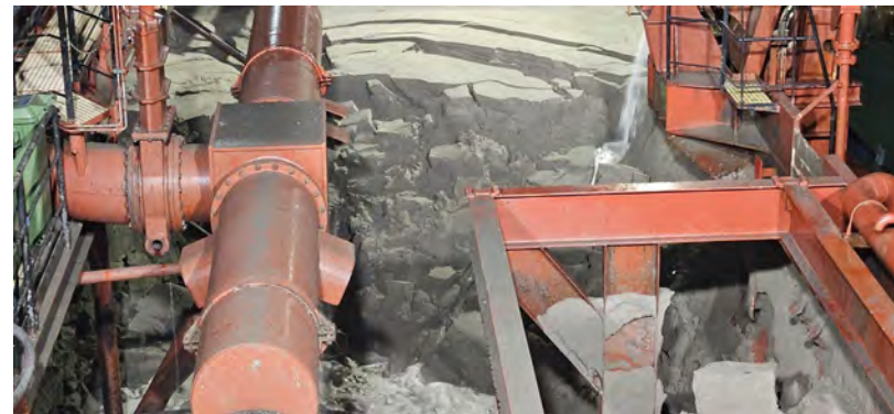
Figura 12 - Seguimiento y control arqueológico de la Fase II de la ampliación de la NTC, a bordo de la Viking R. Supervisión de la 4ª descarga realizada en el turno a través de tubería para el relleno de la dársena.
