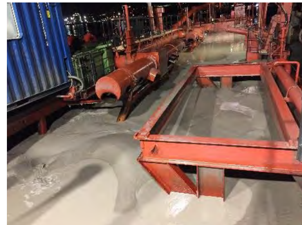
Figura 01 - Seguimiento y control arqueológico del dragado para la Fase II de la ampliación de la NTC, a bordo de la Viking R. Imágenes del proceso de descarga mediante tubería en la dársena.
