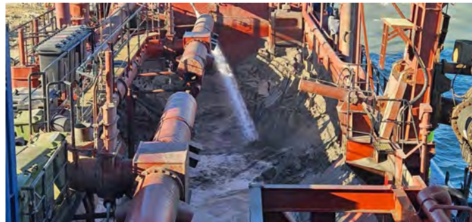
Figura 12 - Seguimiento y control arqueológico de la Fase II de la ampliación de la NTC, a bordo de la Viking R. Supervisión de la 3ª descarga realizada en el turno a través de tubería para el relleno de la dársena.
