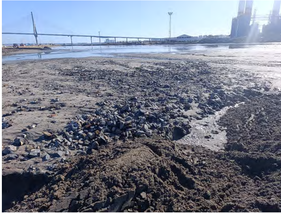
Figura 9. Vertido derelleno.
