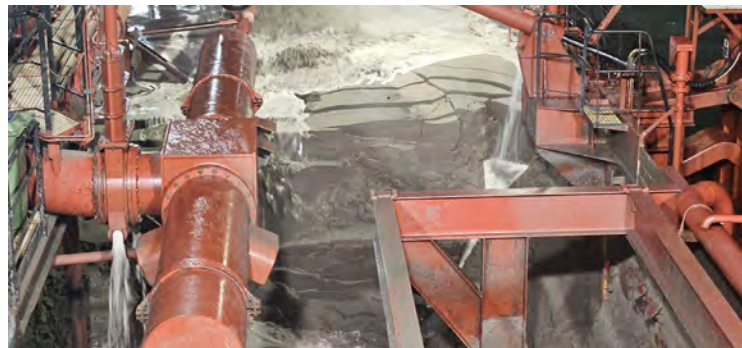
Figura 04 - Seguimiento y control arqueológico de la Fase II de la ampliación de la NTC, a bordo de la Viking R. Supervisión de la 1ª descarga realizada en el turno a través de tubería para el relleno de la dársena.
