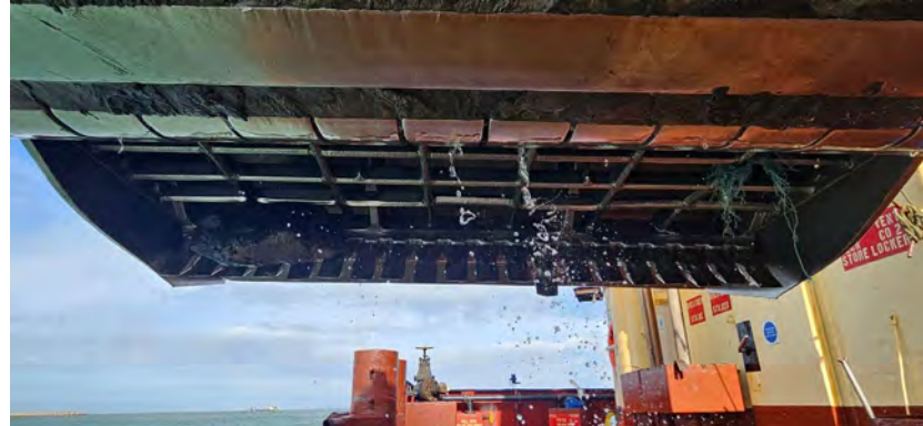
Figura 03 - Seguimiento y control arqueológico del dragado para la Fase II de la ampliación de la NTC, a bordo de la Brage R. Revisión de la limpieza de la cabeza de succión tras la 1ª carga completada en el turno. Material de desecho. Resultado negativo.
