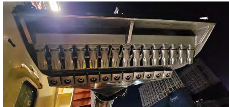
Figura 14 - Seguimiento y control arqueológico del dragado para la Fase II de la ampliación de la NTC, a bordo de la Viking R. Revisión de la cabeza de succión tras la 4ª carga realizada en el turno. Resultado negativo.
