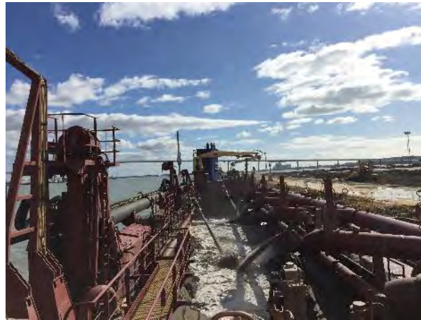
Figura 03 - Seguimiento y control arqueológico del dragado para la Fase II de la ampliación de la NTC, a bordo de la Brage R. Imágenes del proceso de la descarga mediante tubería en la dársena.
