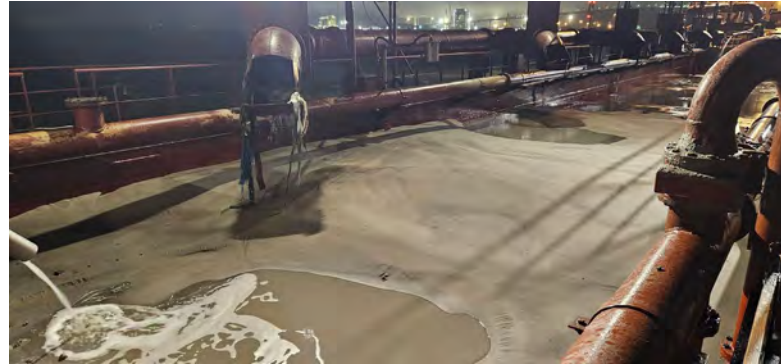
Figura 09 - Seguimiento y control arqueológico del dragado para la Fase II de la ampliación de la NTC, a bordo de la Brage R. Supervisión de la cántara tras la 3ª carga completada. Resultado negativo.
