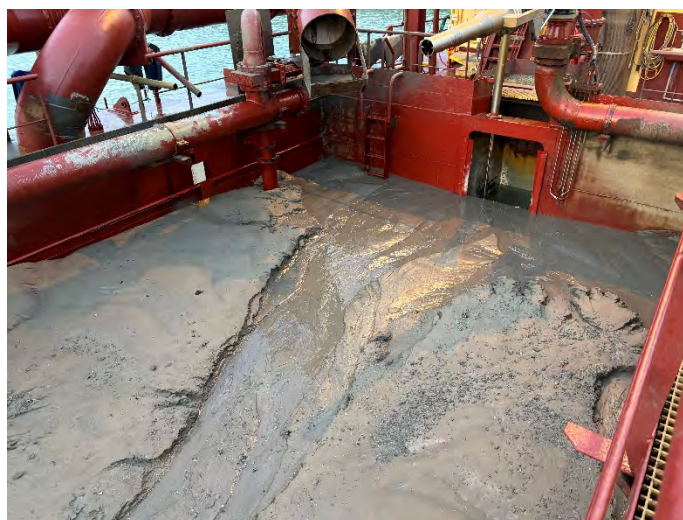
Figura 4. Material dragado utilizado para el relleno dársena interior.
