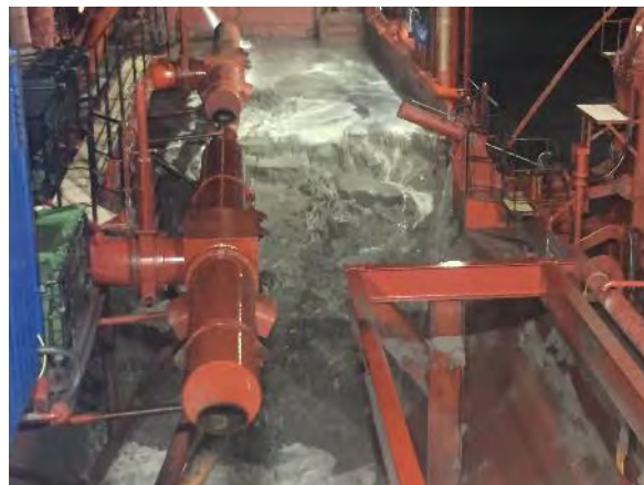
Figura 04 - Seguimiento y control arqueológico del dragado para la Fase II de la ampliación de la NTC, a bordo de la Viking R. Imágenes de los trabajos de descarga del material mediante lanza en el relleno del cajón 8. Resultado negativo.
