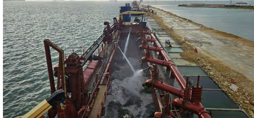
Figura 05 - Seguimiento y control arqueológico de la Fase II de la ampliación de la NTC, a bordo de la Brage R Supervisión de la 1ª descarga realizada en el turno a través de tubería para el relleno de la dársena.
