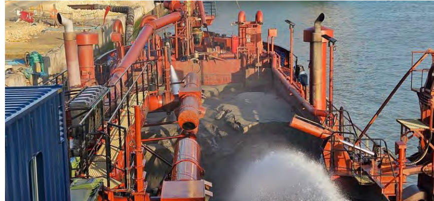
Figura 03 - Seguimiento y control arqueológico de la Fase II de la ampliación de la NTC, a bordo de la Viking R Supervisión de la 1ª descarga realizada en el turno a través de tubería para el relleno de la dársena.
