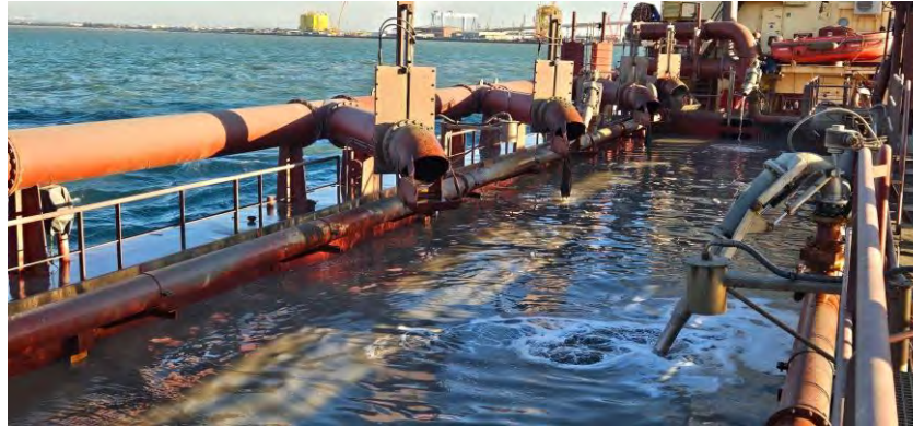
Figura 07 - Seguimiento y control arqueológico del dragado para la Fase II de la ampliación de la NTC, a bordo de la Brage R. Supervisión de la cántara tras la 2ª carga completada. La cantidad de agua mantenida a bordo no permite la revisión del material extraído. Resultado negativo.
