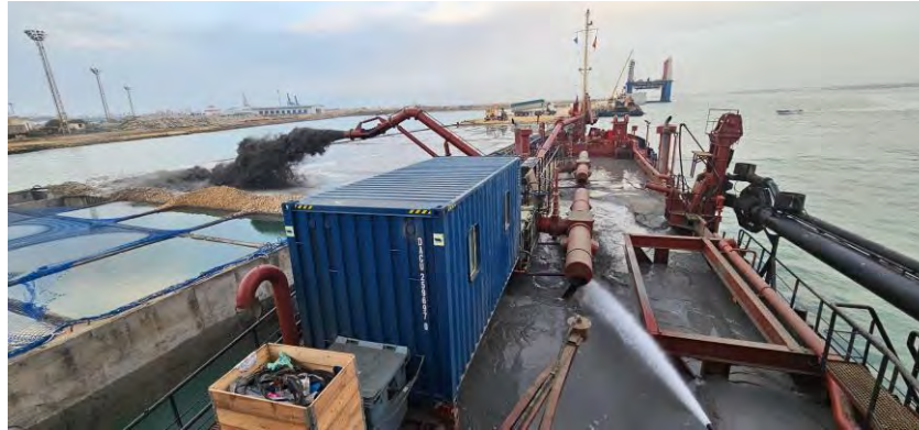
Figura 03 - Seguimiento y control arqueológico de la Fase II de la ampliación de la NTC, a bordo de la Viking R. Supervisión de la 3ª descarga realizada en el turno a través de lanza para el relleno del cajón 06.
