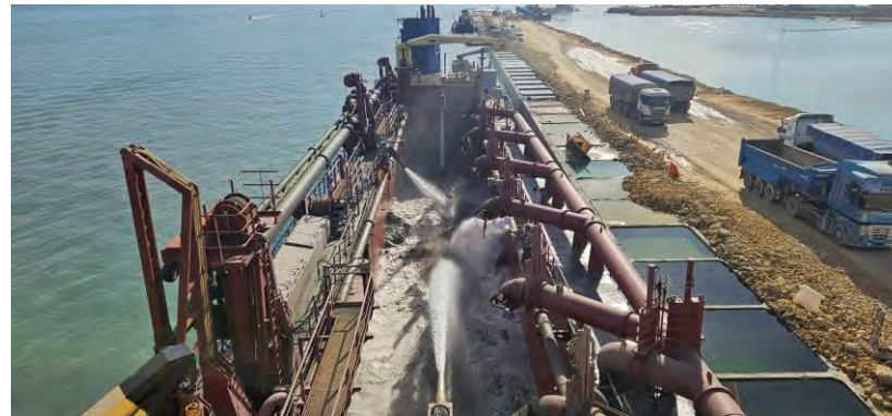
Figura 04 - Seguimiento y control arqueológico de la Fase II de la ampliación de la NTC, a bordo de la Brage R. Supervisión de la 2ª descarga realizada en el turno a través de tubería para el relleno de la dársena.
