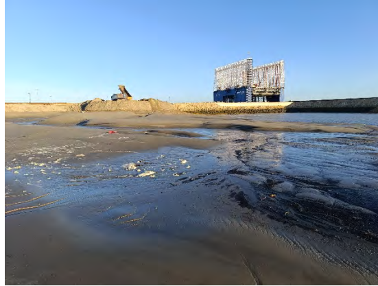
Figura 5. Relleno interior de la nueva plataforma.
