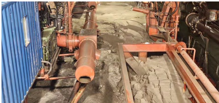
Figura 07 - Seguimiento y control arqueológico de la Fase II de la ampliación de la NTC, a bordo de la Viking R Supervisión de la 4ª descarga realizada en el turno a través de lanza para el relleno del cajón 06.
