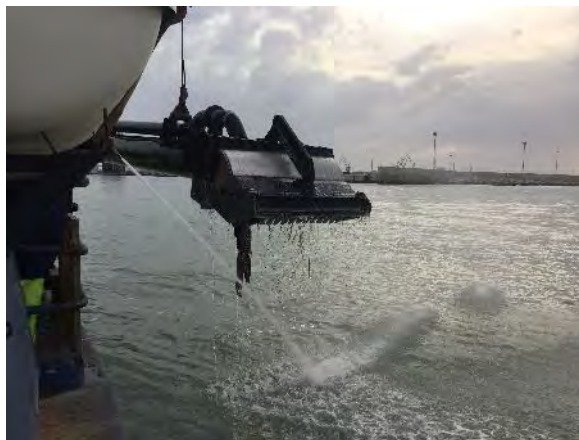
Figura 04 - Seguimiento y control arqueológico del dragado para la Fase II de la ampliación de la NTC, a bordo de la Viking R. Imágenes de cabezal de succión con residuos actuales y del sedimento extraído durante proceso de la 4ª descarga. Resultado negativo.
