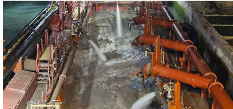
Figura 01 - Seguimiento y control arqueológico de la Fase II de la ampliación de la NTC, a bordo de la Brage R Supervisión de la 1ª descarga realizada en el turno a través de tubería para el relleno de la dársena.
