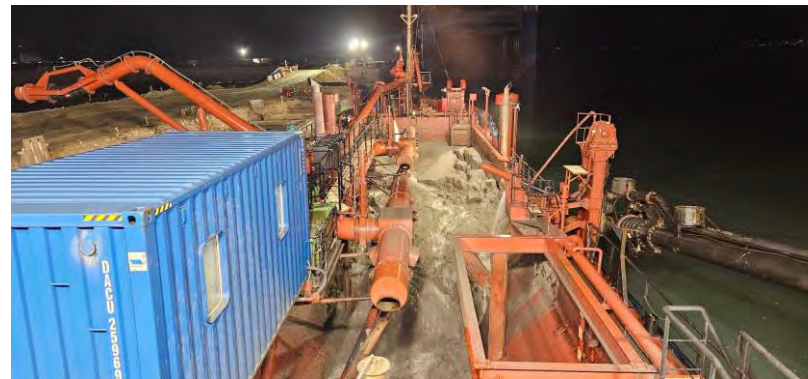
Figura 06 - Seguimiento y control arqueológico de la Fase II de la ampliación de la NTC, a bordo de la Viking R. Supervisión de la 2ª descarga realizada en el turno a través de tubería para el relleno de la dársena.
