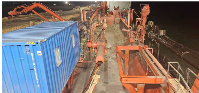
Figura 03 - Seguimiento y control arqueológico de la Fase II de la ampliación de la NTC, a bordo de la Viking R Supervisión de la 2ª descarga realizada en el turno a través de lanza para el relleno del cajón 06.
