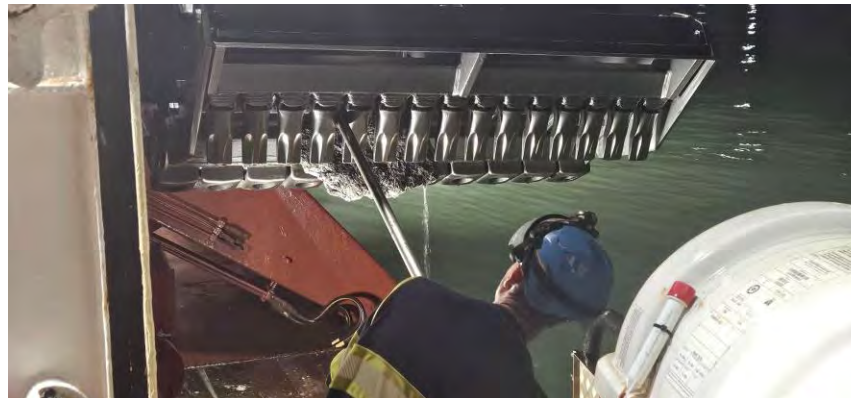
Figura 04 - Seguimiento y control arqueológico del dragado para la Fase II de la ampliación de la NTC, a bordo de la Viking R. Revisión de la limpieza de la cabeza de succión tras la 4ª carga completada en el turno. Material de desecho. Resultado negativo.
