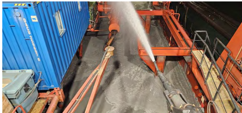
Figura 08 - Seguimiento y control arqueológico de la Fase II de la ampliación de la NTC, a bordo de la Viking R. Supervisión de la 2ª y última descarga realizada en el turno a través de tubería para el relleno de la dársena.
