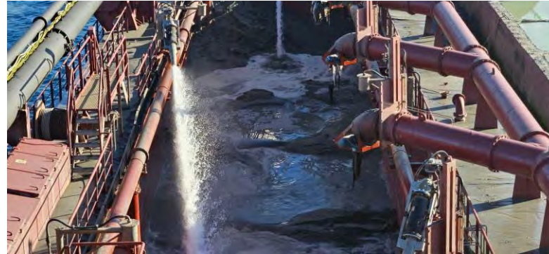
Figura 09 - Seguimiento y control arqueológico de la Fase II de la ampliación de la NTC, a bordo de la Brage R Supervisión de la 2ª descarga realizada en el turno a través de tubería para el relleno de la dársena.
