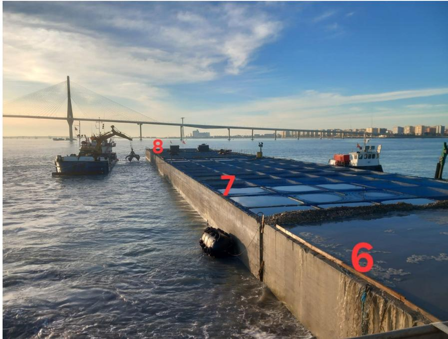
*Figura 5. Cajones colocados y pendientes de relleno.*
