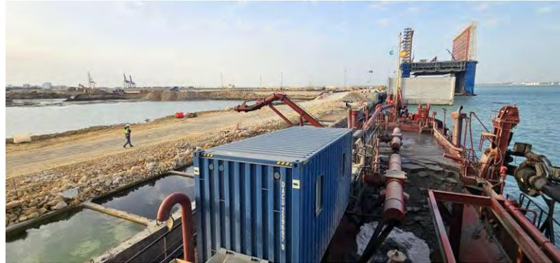
Figura 03 - Seguimiento y control arqueológico de la Fase II de la ampliación de la NTC, a bordo de la Viking R. Supervisión de la 4ª descarga realizada en el turno a través de tubería para el relleno de la dársena.
