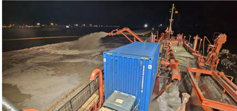
Figura 03 - Seguimiento y control arqueológico de la Fase II de la ampliación de la NTC, a bordo de la Viking R. Supervisión de la 4ª descarga realizada en el turno a través de lanza para el relleno del cajón 05.
