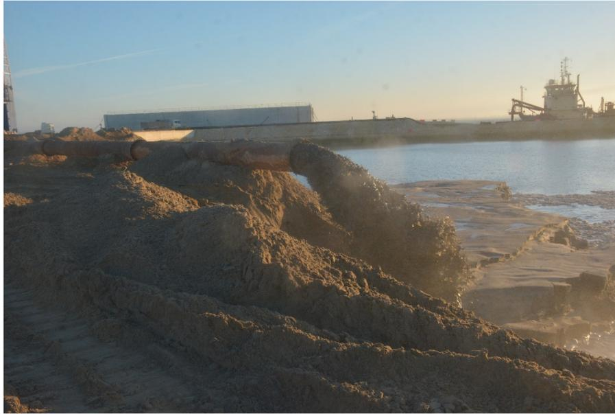
*Figura 7. Relleno interior mediante tubería.*
