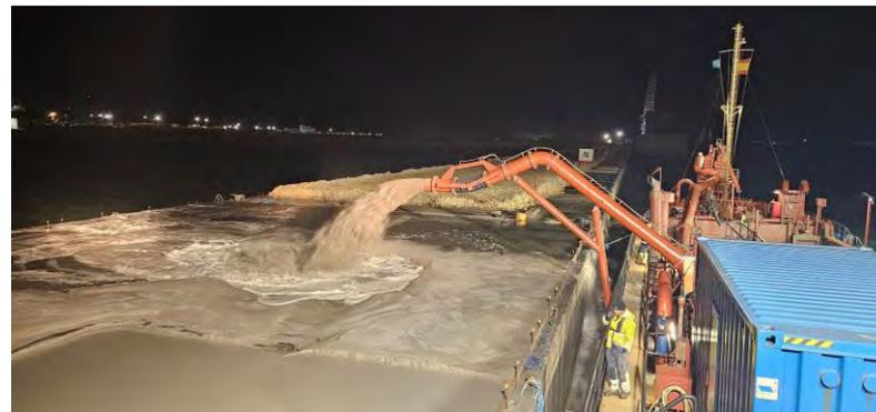
Figura 04 - Seguimiento y control arqueológico de la Fase II de la ampliación de la NTC, a bordo de la Viking R. Supervisión de la 3ª descarga realizada en el turno a través de lanza para el relleno del cajón 05.
