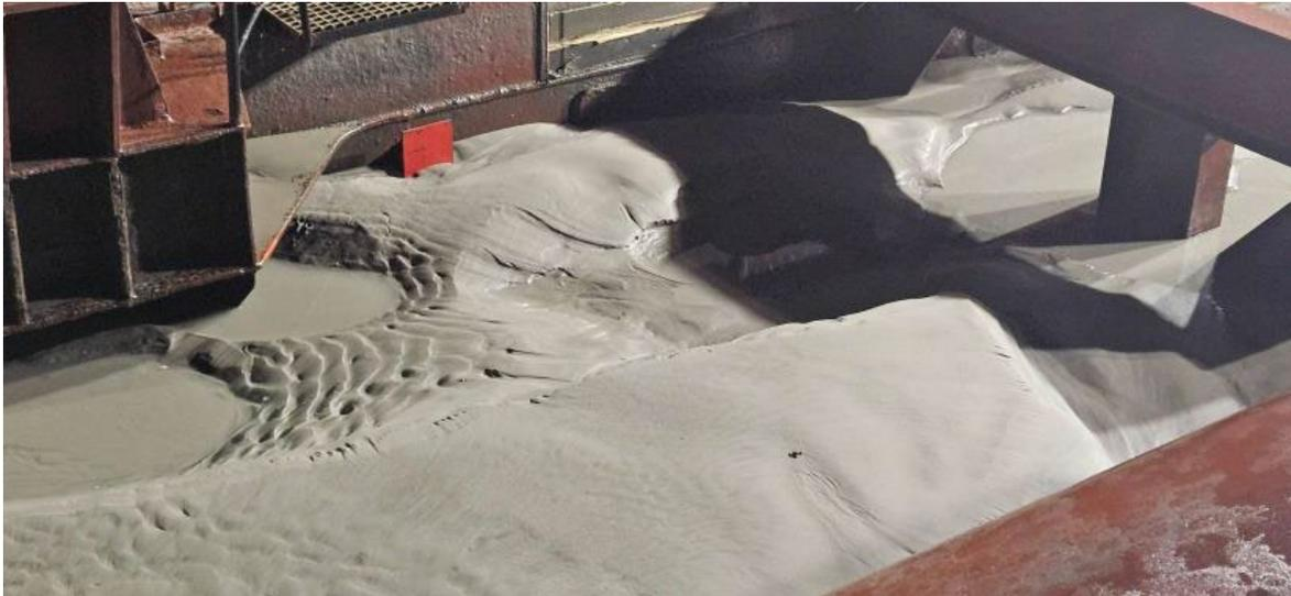
*Figura 4. Material dragado utilizado para el relleno de cajones y dársena interior.*
