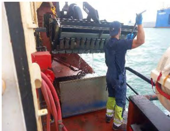
Figura 03 - Seguimiento y control arqueológico del dragado para la Fase II de la ampliación de la NTC, a bordo de la Viking R. Limpieza de la cabeza de succión tras de la segunda carga. Resultado negativo.
