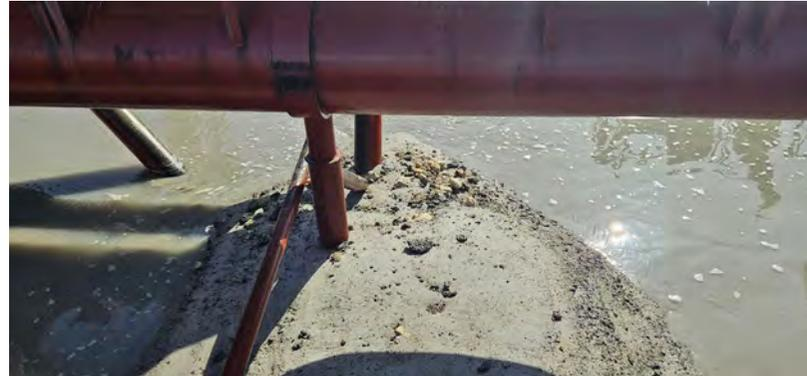
Figura 03 - Seguimiento y control arqueológico del dragado para la Fase II de la ampliación de la NTC, a bordo de la Viking R. Supervisión de la cántara tras la 1ª carga del turno, detalle del tipo de sedimento (fangos, limos arenosos y piedras).
