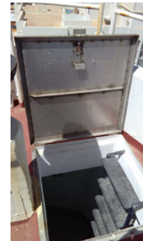
Vista de trampilla en Faro de Barbate
