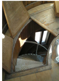
Vista de trampilla en Faro de Cádiz
