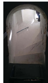
Vista de escalera de ascenso en Faro de Sancti Petri.
