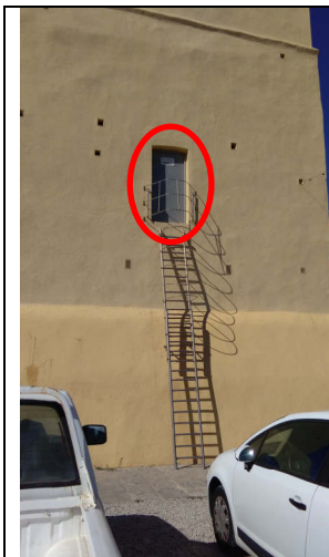
Vista de acceso en Faro de Roche situado en altura.
