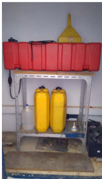
Zona de almacenamiento de Gasoil en Faro de Cádiz.
